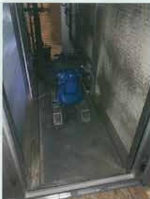
PRENANT EN COMPTE L'HYGROMÉTRIE EXTÉRIEURE ET LA TEMPÉRATURE, L'ORDINATEUR CENTRAL PILOTE LE BON FONCTIONNEMENT DU SÉCHOIR EN GRANGE. C'EST LUI QUI DÉCLENCHE LA MISE EN ROUTE DU DÉSHUMIDIFICATEUR.
