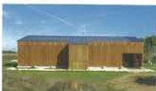
Ce panneau solaire thermovoltaïque produit de l'électricité et de l'air chaud. Des échangeurs thermiques récupèrent la chaleur au dos du panneau, qui produit trois fois plus de chaleur que d'électricité. L'air chaud est utilisé en séchage en grange (fourrage, bois, copeaux, etc.), selon un principe de ventilation identique aux granges solaires à toiture fibrociment, mais avec un rendement 2 à 3 fois supérieur.
